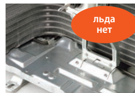
С электрическим нагревателем поддона
