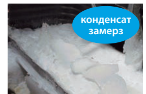
Без электрического нагревателя поддона
