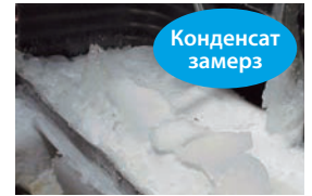
Без электрического нагревателя поддона
