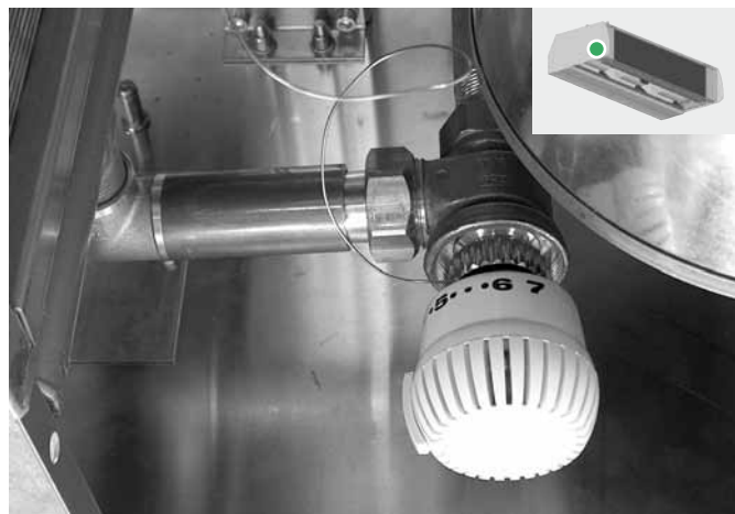
РИС. 14 – ТЕРМОСТАТИЧЕСКИЙ ВЕНТИЛЬ TVW-R (D2)
